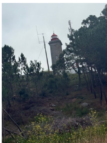
Faro, Castro de Montedor
