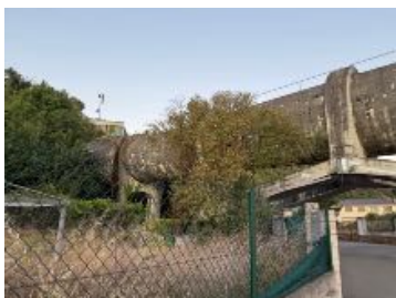
Tubul de alimentare cu apă Ponferrada
