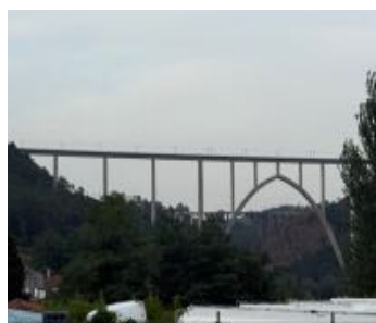
Viaducte peste viaducte
