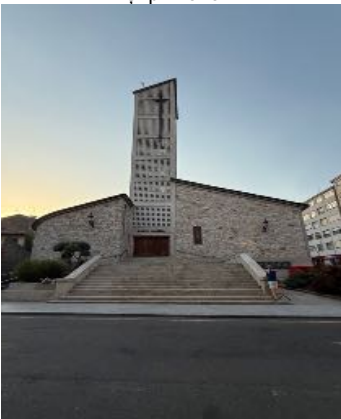
Iglesia parohială Santa Marina
