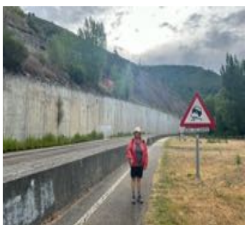
Sus e autostrada
