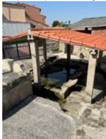
Spălătoria locală din Angueira de Suso
