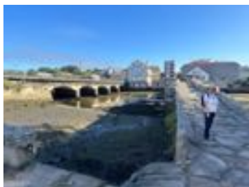
Ponte Sobre o Rio Miñor
