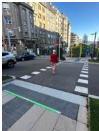
Construcție urbană ingenioasă (Gran Via)
